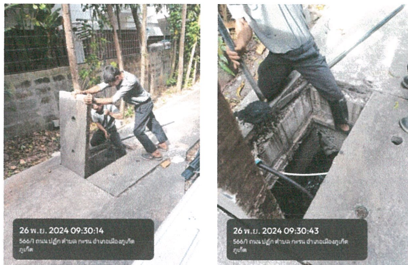
รูปภาพที่ 2.15 การขุดลอกตะกอน
