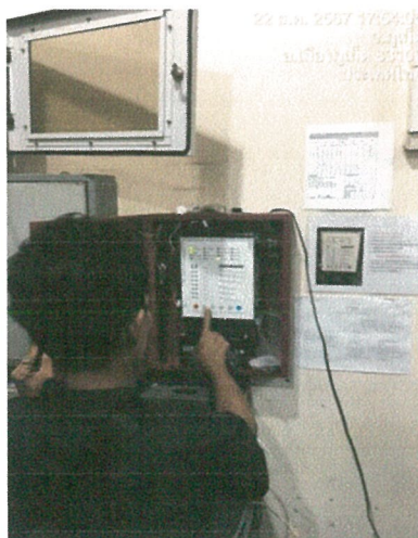
รูปภาพที่ 2.21 การตรวจสอบอุปกรณ์ป้องกันและแจ้งเตือนอัคคีภัย
