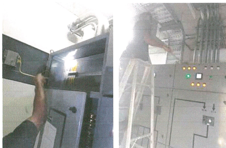
รูปภาพที่ 2.33 การซ่อมบำรุงไฟฟ้าระบบส่วนกลาง
