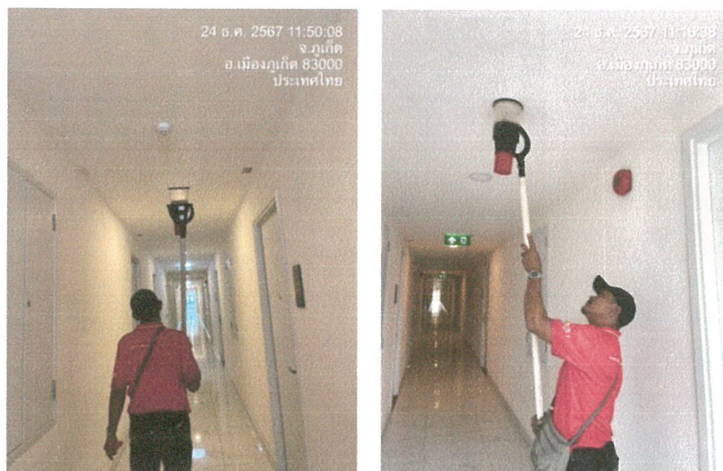
รูปภาพที่ 2.55 การตรวจสอบอุปกรณ์ป้องกันอัคคีภัย
