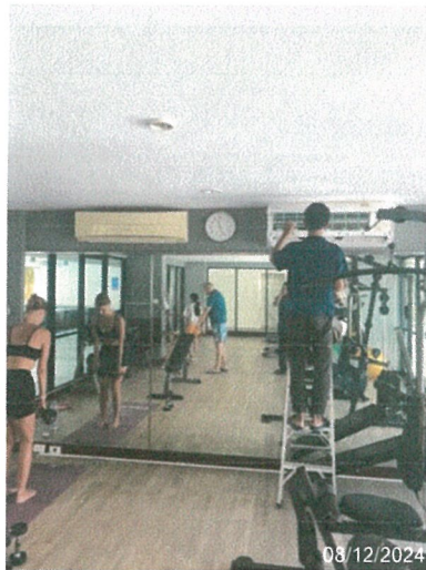
รูปภาพที่ 2.48 การล้างทำความสะอาดเครื่องปรับอากาศ
