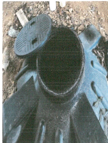
รูปภาพที่ 2.9 ระบบบำบัดน้ำเสียสำเร็จรูปของโรงแรม
