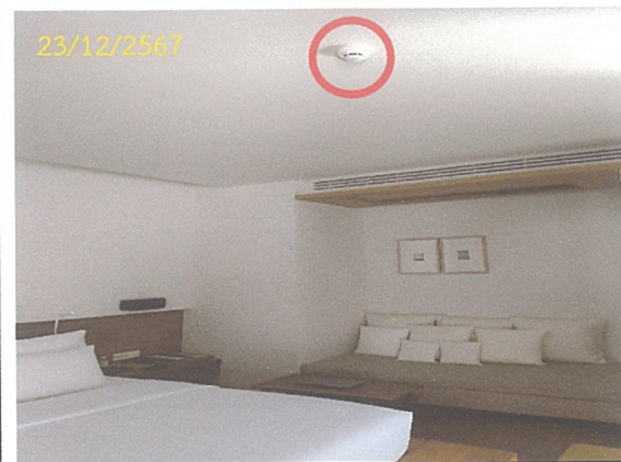
รูปที่ 2-13 อุปกรณ์ตรวจจับควันภายในห้องพักแรม
