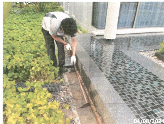
รูปภาพที่ 2.21 การขุดลอกตะกอน
