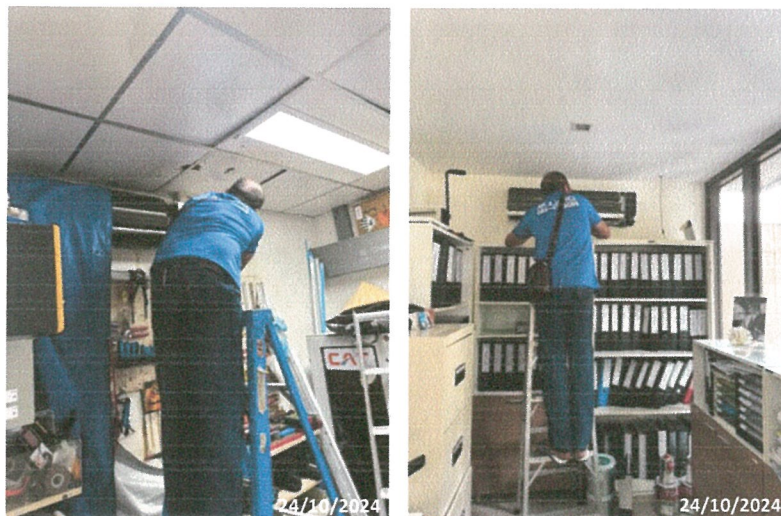
รูปภาพที่ 2.28 การล้างทำความสะอาดแอร์
