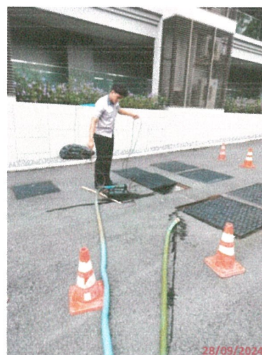
รูปภาพที่ 2.73 การสูบละกอน
