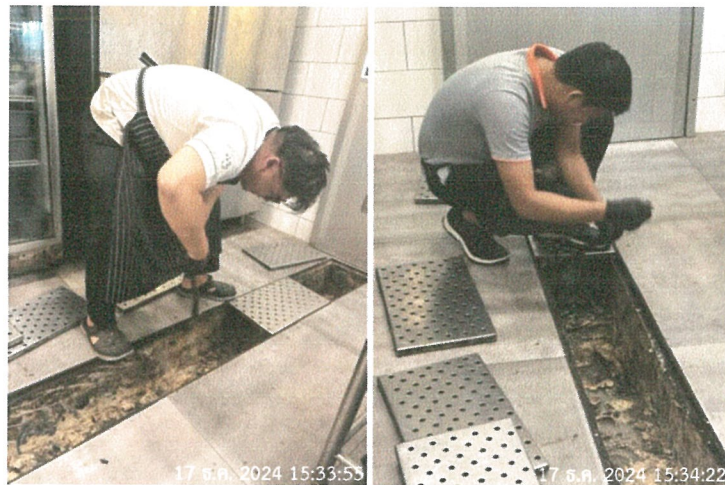
รูปภาพที่ 2.8 การขุดลอกตะกอน
