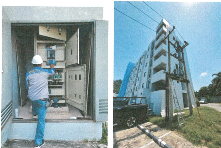
รูปภาพที่ 2.39 การตรวจสอบหม้อแปลงไฟฟ้า
