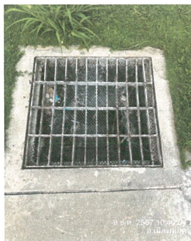
รูปภาพที่ 2.12 ตะแกรงดักขยะและรางระบายน้ำ
