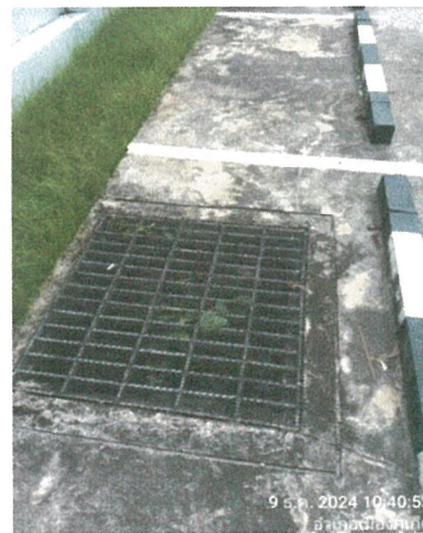
รูปภาพที่ 2.12 ตะแกรงดักขยะและรางระบายน้ำ
