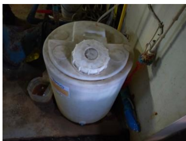
ระบบเติมคลอรีนถังพักน้ำ
