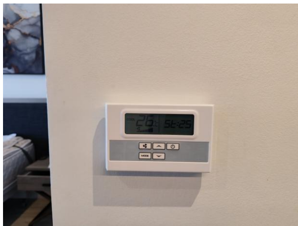
ชุดควบคุมอุณหภูมิห้องปรับอากาศ
