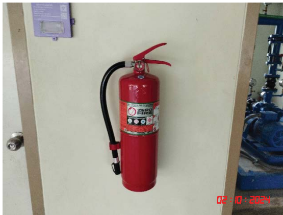
เครื่องดับเพลิงเคมีชนิดมือถือ
