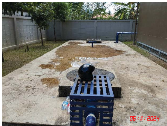
รูปที่ 9 บ่อหน่วงน้ำและท่อระบายน้ำของโครงการ
