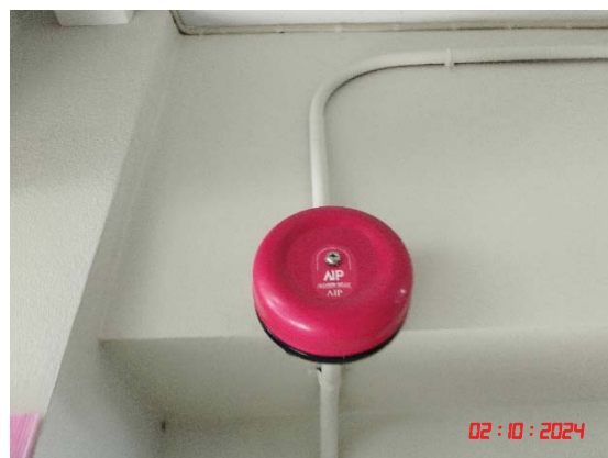
ระบบส่งสัญญาณเตือนภัยแบบกริ่ง
