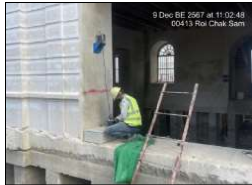
ภาพที่ 90 ติดตั้งเครื่องมือตรวจวัดทางธรณีเทคนิค
