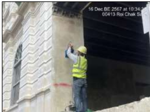
ภาพที่ 90 ติดตั้งเครื่องมือตรวจวัดทางธรณีเทคนิค
