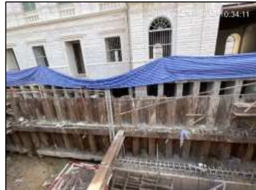
ภาพที่ 82 Sheet Pile และระบบค้ำยัน
