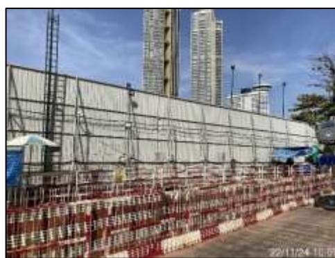
ภาพที่ 2 รั้ว Metal Sheet 6 เมตร
