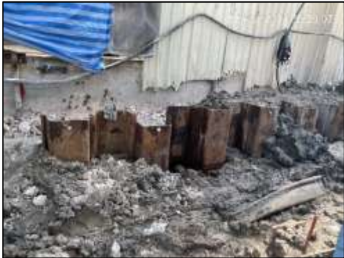
ภาพที่ 82 Sheet Pile และระบบค้ำยัน
