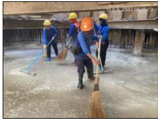
ภาพที่ 6 (ต่อ) กวาดฝุ่นละอองและตะกอนภายหลังการฉีดพรมน้ำ
