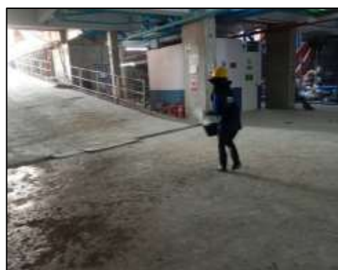
ภาพที่ 5 กิจกรรมฉีดพรมน้ำบริเวณพื้นที่ก่อสร้าง
