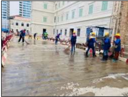
ภาพที่ 6 (ต่อ) กวาดฝุ่นละอองและตะกอนภายหลังการฉีดพรมน้ำ
