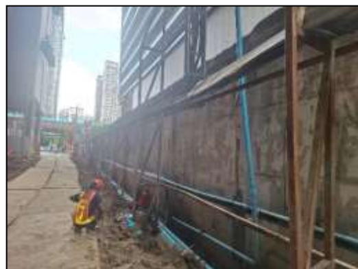
ภาพที่ 16 ตรวจสอบจุดรั่วซึมของเส้นท่อประปา
