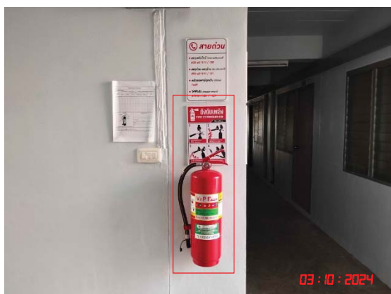
เครื่องดับเพลิงเคมีพร้อมทั้งวิธีการใช้ และแบบบันทึกการตรวจสอบการใช้งาน
