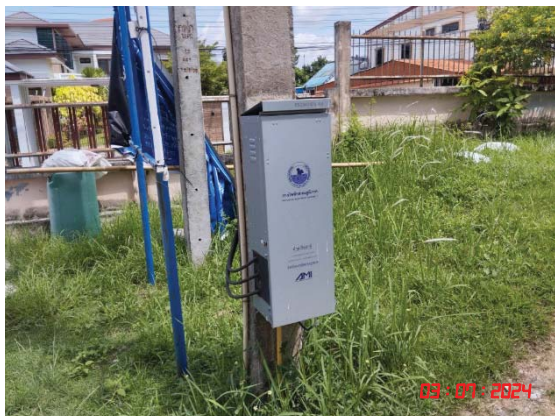
มิเตอร์ไฟฟ้าระบบ AMI
