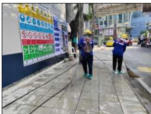
ภาพที่ 15 ฉีดพรมน้ำบริเวณพื้นที่ก่อสร้าง และกวาดทำความสะอาด
