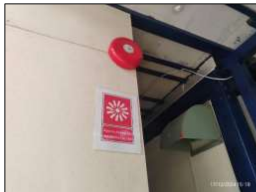
ภาพที่ 56 เครื่องแจ้งเหตุเพลิงไหม้ด้วยลำโพง
