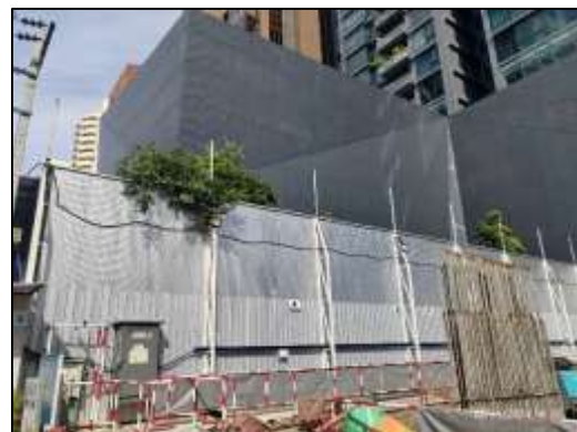
ภาพที่ 8 รั้ว Metal Sheet กรุด้วยฉนวนกันเสียง Isonoise
