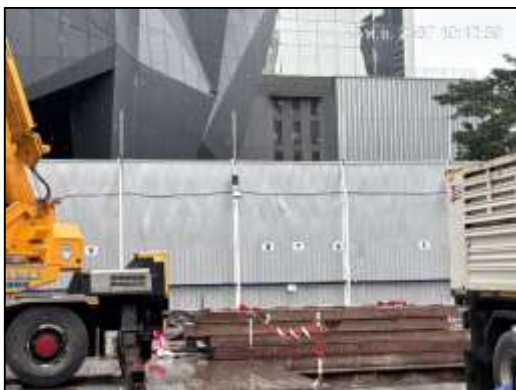
ภาพที่ 8 รั้ว Metal Sheet กรุด้วยฉนวนกันเสียง Isonoise
