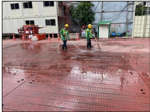
ภาพที่ 5 ฉีดพรมน้ำบริเวณพื้นที่ก่อสร้าง
