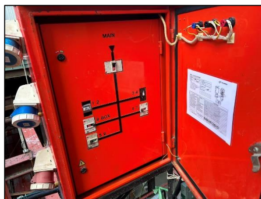
ภาพที่ 32 อุปกรณ์ตัดกระแสไฟฟ้า
