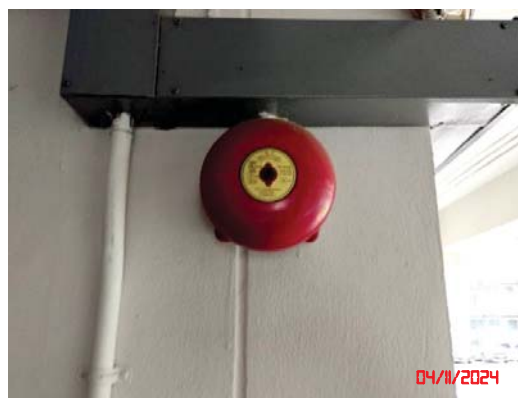
กระดิ่งสัญญาณเตือนไฟไหม้
