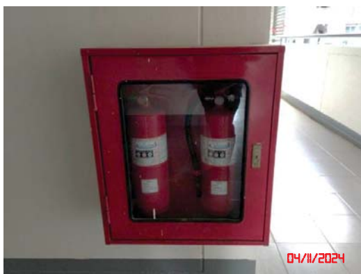
ถังดับเพลิงชนิดผงเคมีแห้งแบบมือถือ
