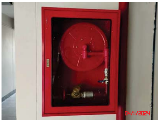
ตู้สายฉีดน้ำดับเพลิง
