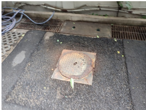
ภาพที่ 4-5 ฝาถังตกตะกอนและบ่อกักน้ำทิ้งก่อนปล่อยออกสู่ท่อระบายสาธารณะ
