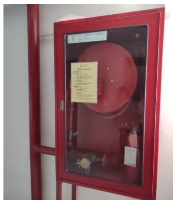
ภาพที่ 4-23 ตู้เก็บสายฉีดน้ำดับเพลิงพร้อมอุปกรณ์
