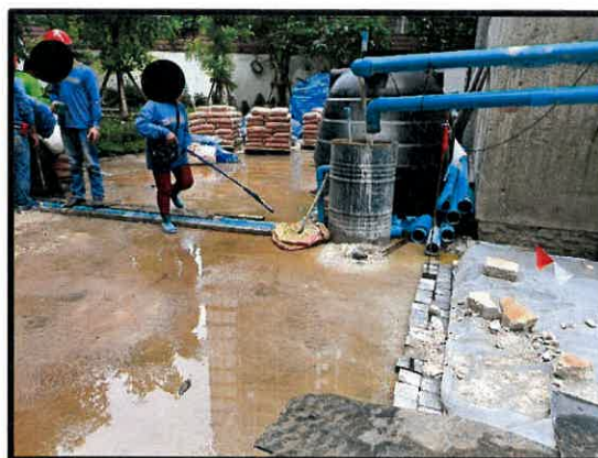
รูปที่ 3-12 ถังบำบัดน้ำเสียในพื้นที่ก่อสร้าง
