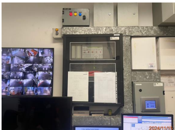
รูปที่ 3-38 Fire Alarm Control Panel ห้องควบคุม
