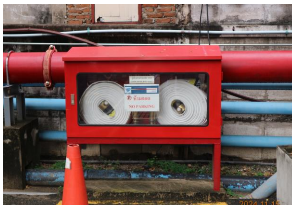
รูปที่ 3-41 ตู้เก็บสายน้ำดับเพลิงพร้อมอุปกรณ์
