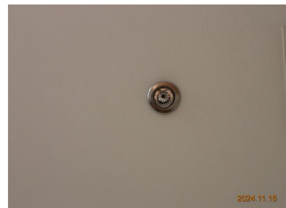
รูปที่ 3-43 ระบบหัวกระจายน้ำดับเพลิง
