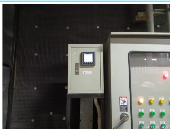
รูปที่ 3-15 มิเตอร์ไฟฟ้าของส่วนระบบบำบัดน้ำเสีย
