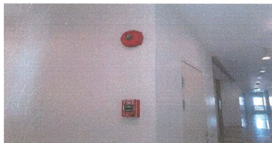
กริ่งสัญญาณเตือนภัย เครื่องแจ้งเหตุโดยใช่มือดึง
