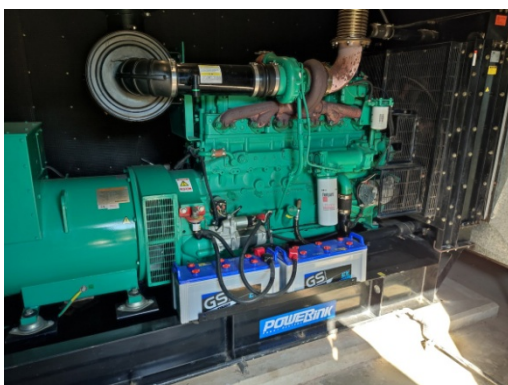
ภาพที่ 3-32 เครื่องกำเนิดไฟฟ้าฉุกเฉิน มีฉนวนกันเสียงดังอยู่ภายในห้อง
