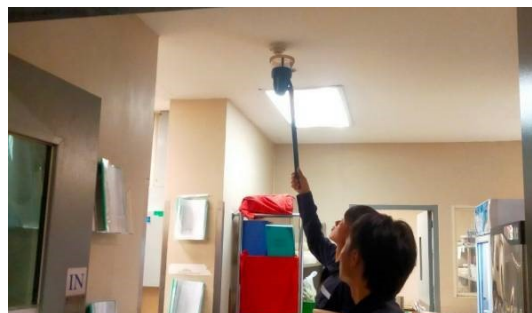
ภาพที่ 3-26 ตรวจสอบระบบป้องกันและเตือนอัคคีภัย พร้อมใช้งาน
