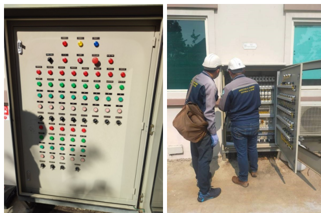
ภาพที่ 3-11 แผงมิเตอร์แผงควบคุมระบบบำบัดน้ำเสียโดยเฉพาะ ตรวจสอบและบำรุงรักษาอย่างสม่ำเสมอ
