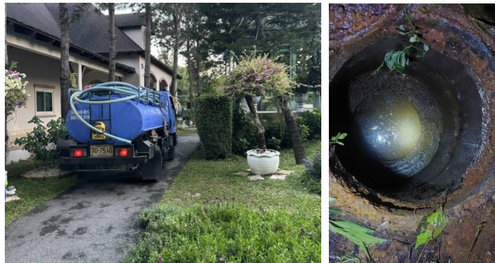
ภาพที่ 3-10 สูบตะกอนไขมันออกจากถังแยกตะกอน
