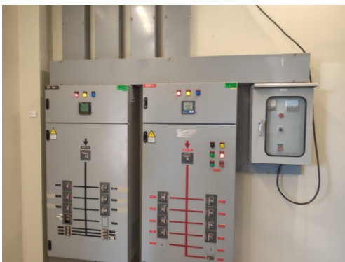
ภาพที่ 3-31 ห้องไฟฟ้าประจำอาคาร และป้ายเตือนหน้าห้องให้ระวังอันตรายจากไฟฟ้าช็อต
