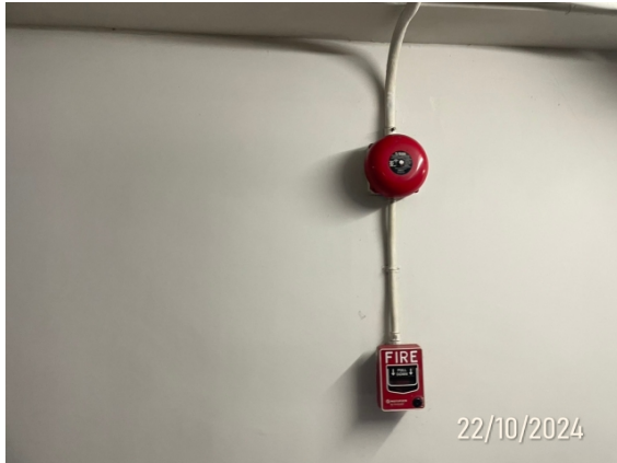
กริ่งแจ้งเตือนเพลิงไหม้ (Alam Bell)
