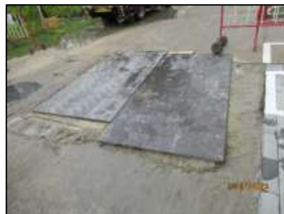
รูปที่ 20 การปูแผ่นเหล็ก (Platform) เพื่อลดแรงสั่นสะเทือนจากการเดินรถภายในพื้นที่โครงการที่มีระดับพื้นต่างกัน
