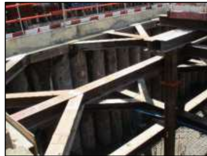
รูปที่ 24 ระบบป้องกันดินพัง ระบบ Pile wall และค้ำยันเหล็ก (Bracing)
