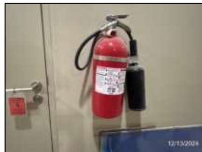
รูปที่ 35 ถังดับเพลิงเคมี-ป้ายแนะนำการใช้ถังดับเพลิง
