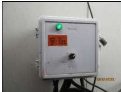
รูปที่ 39 แผงควบคุมไฟฟ้า และเครื่องตัดกระแสไฟฟ้าอัตโนมัติ
