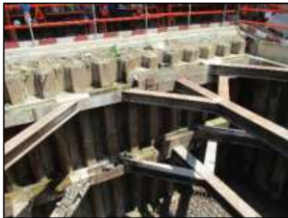
รูปที่ 24 ระบบป้องกันดินพัง ระบบ Pile wall และค้ำยันเหล็ก (Bracing)
