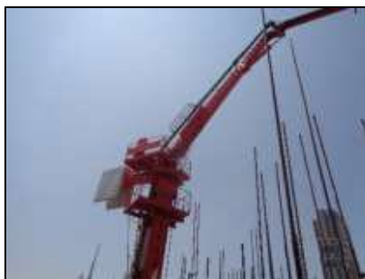
รูปที่ 58 เครนเป็นแบบพับแขนได้และแขนของเครนจะต้องอยู่เฉพาะภายในพื้นที่โครงการเท่านั้นไม่ล้ำไปยังพื้นที่ข้างเคียง
