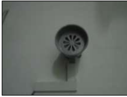
รูปที่ 42 อุปกรณ์แจ้งเหตุเตือนเพลิงไหม้โดยติดตั้งลำโพงกระจายเสียง
