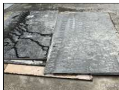
รูปที่ 20 การปูแผ่นเหล็ก (Platform) เพื่อลดแรงสั่นสะเทือนจากการเดินรถภายในพื้นที่โครงการที่มีระดับพื้นต่างกัน
