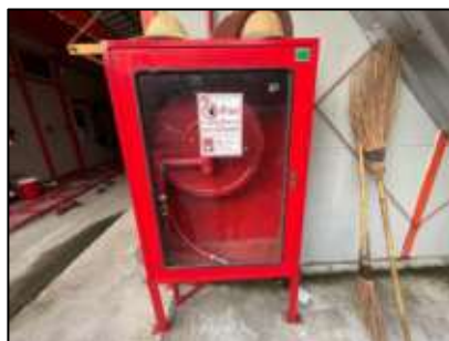
รูปที่ 65 หัวฉีดน้ำดับเพลิง และถังดับเพลิงชนิดมือถือ บริเวณบ้านพักคนงาน
