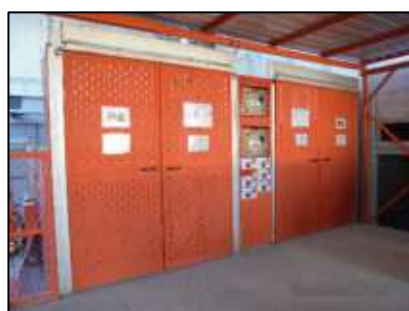
รูปที่ 57 ลิฟต์ขนส่งวัสดุชั่วคราว และลิฟต์โดยสารชั่วคราว
