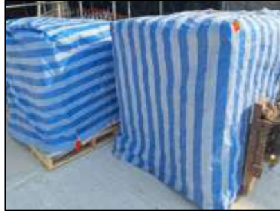
รูปที่ 5 กองวัสดุที่มีฝุ่นหรือเศษวัสดุที่เหลือใช้ ปิดคลุมด้วยผ้าใบมิดชิด
