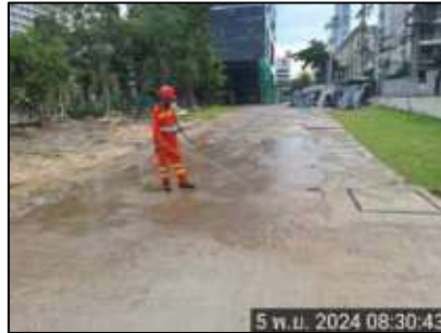
รูปที่ 14 สเปรย์ละอองน้ำบริเวณรั้ว Metal Sheet รอบโครงการ และคนงานคอยฉีดพรมน้ำบริเวณพื้นที่ก่อสร้าง
