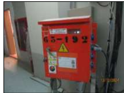
รูปที่ 39 แผงควบคุมไฟฟ้า และเครื่องตัดกระแสไฟฟ้าอัตโนมัติ
