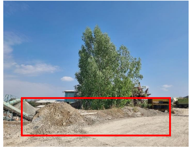
รูปที่ 2-9ข.แนวคันทำนบดินรอบพื้นที่โรงโม่หิน
