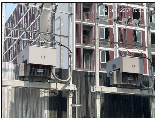
ภาพที่ 29 หม้อแปลงไฟฟ้า
