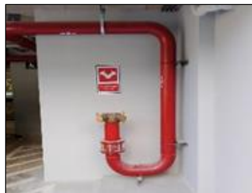
ภาพที่ 60 หัวจ่ายดับเพลิง และหัวรับน้ำดับเพลิง
