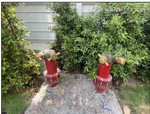
ภาพที่ 60 หัวจ่ายดับเพลิง และหัวรับน้ำดับเพลิง
