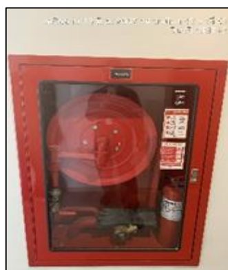
ภาพที่ 15 ตู้เก็บสายฉีดน้ำดับเพลิงและถังดับเพลิง
