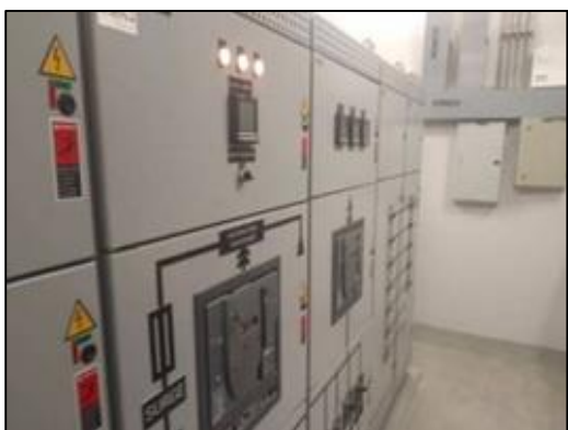
ภาพที่ 16 คัตเอาต์ตัดกระแสไฟฟ้า
