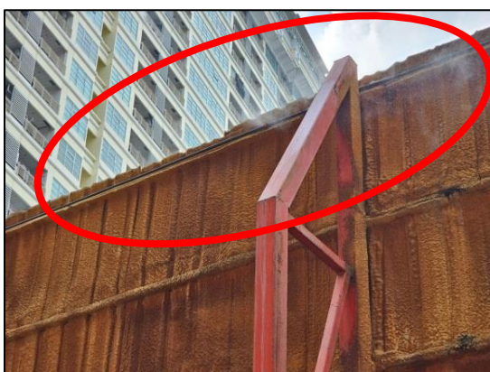
รูปที่ 15 ติดตั้งระบบแผ่นรองสเปรย์น้ำ บริเวณรั้ว Metal Sheet รอบโครงการ
