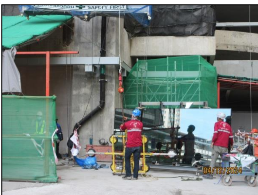
รูปที่ 45 การขนย้ายวัสดุขนาดใหญ่อย่างระมัดระวังเพื่อความปลอดภัยจากการตกลงและไม่ก่อให้เกิดเสียง
