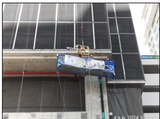
รูปที่ 45 การขนย้ายวัสดุขนาดใหญ่อย่างระมัดระวังเพื่อความปลอดภัยจากการตกลงและไม่ก่อให้เกิดเสียง
