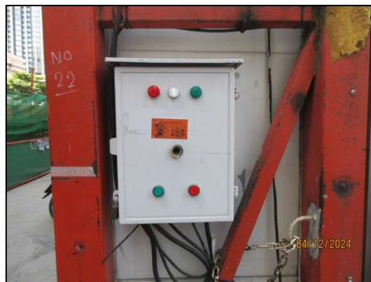
รูปที่ 42 ติดตั้งเครื่องแจ้งเหตุเตือนเพลิงไหม้ ด้วยเสียง Alarm Bell
