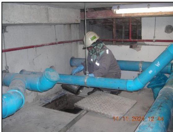
รูปที่ 3.6 การเก็บตัวอย่างคุณภาพน้ำทิ้ง บริเวณบ่อเกรอะของระบบบำบัดน้ำเสียรวม
