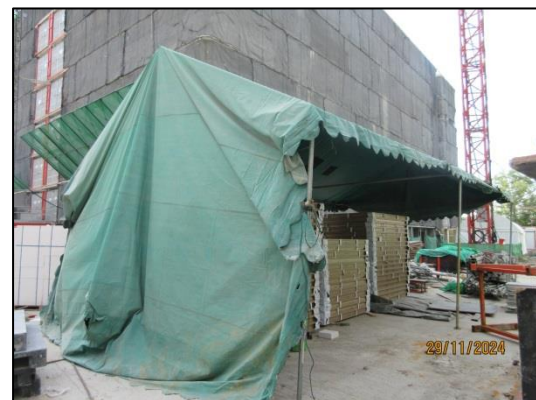
รูปที่ 51 พื้นที่ในการตัด/การเชื่อมต่อโลหะ อุปกรณ์ที่กำบังสะเก็ดไฟในพื้นที่ก่อสร้าง
