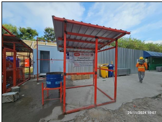
รูปที่ 46 ถังดับเพลิงเคมีอย่างเพียงพอ ภายในพื้นที่โครงการ และติดป้ายแนะนำการใช้งาน
