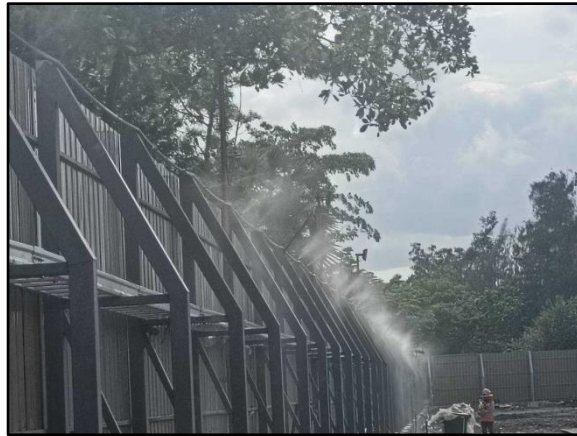
รูปที่ 8 เจ้าหน้าที่ฉีดน้ำเพื่อลดฝุ่นละออง บริเวณพื้นที่ทำการรื้อถอน
