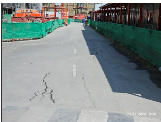
รูปที่ 33 ปูแผ่นเหล็กอย่างหนา และจัดทำถนนคอนกรีตชั่วคราวบริเวณภายในพื้นที่โครงการ
