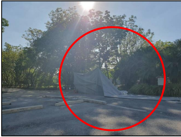
รูปที่ 7 ติดตั้ง Mesh Sheet (ชนิดกันไฟลาม) โดยรอบพื้นที่รื้อถอน และใช้ผ้าคลุมบริเวณพื้นที่กองเศษวัสดุจากการรื้อถอน
