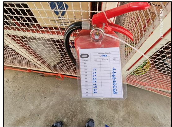
รูปที่ 46 ถังดับเพลิงเคมีอย่างเพียงพอ ภายในพื้นที่โครงการ และติดป้ายแนะนำการใช้งาน
