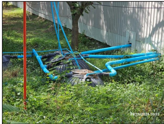
รูปที่ 40 ระบบบำบัดน้ำเสียชนิดเติมอากาศ
