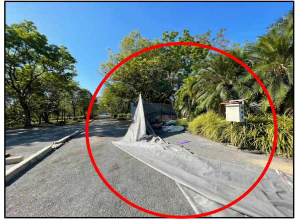
รูปที่ 7 ติดตั้ง Mesh Sheet (ชนิดกันไฟลาม) โดยรอบพื้นที่รื้อถอน และใช้ผ้าคลุมบริเวณพื้นที่กองเศษวัสดุจากการรื้อถอน
