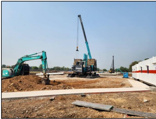
รูปที่ 36 การตอกเสาเข็ม และใช้ผ้ากระสอบหุ้มหัวเสาเข็ม
