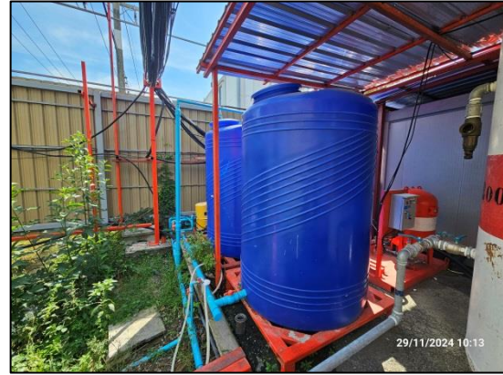
รูปที่ 40 ระบบบำบัดน้ำเสียชนิดเติมอากาศ
