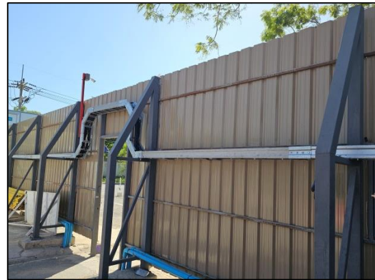
รูปที่ 15 ติดตั้งรางเก็บสายไฟบริเวณโดยรอบโครงการ และไม่ใช่ชุดสายพ่วงต่อพ่วงกันหลายชั้น
