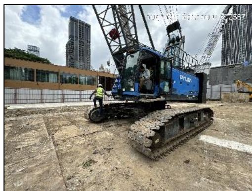
รูปที่ 28 การปูแผ่นเหล็ก (Platform)
