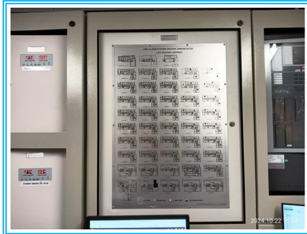
แผงควบคุมระบบสัญญาณแจ้งเหตุเพลิงไหม้ (Fire Alarm Control Panel : FCP)
