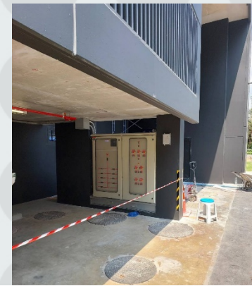
ตู้ไฟฟ้าควบคุมระบบบำบัดน้ำเสีย
