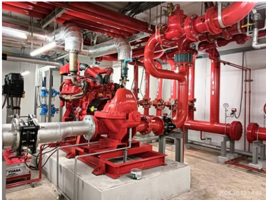
รูปที่ 3-69 ระบบส่งน้ำไปยังอุปกรณ์ดับเพลิง
