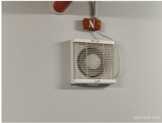
รูปที่ 3-38 พัดลมดูดอากาศประจำห้องพักขยะเปียก
