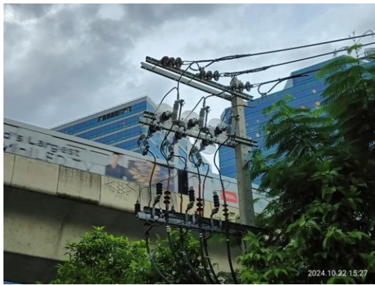
รูปที่ 3-26 หม้อแปลงไฟฟ้า
