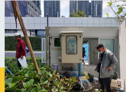
ตู้ไฟฟ้าควบคุมระบบบำบัดน้ำเสีย
