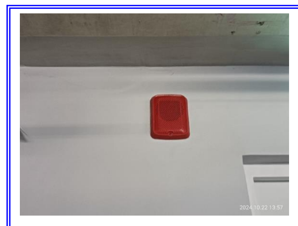
รูปที่ 3-66 อุปกรณ์ส่งสัญญาณแบบเสียง
