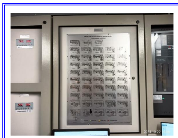
รูปที่ 3-65 แผงควบคุมระบบสัญญาณแจ้งเหตุเพลิงไหม้
