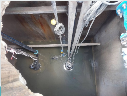
เครื่องสูบน้ำ บ่อหนองน้ำฝน
