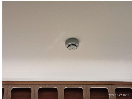
รูปที่ 3-68 เครื่องตรวจจับควัน และตรวจจับความร้อน
