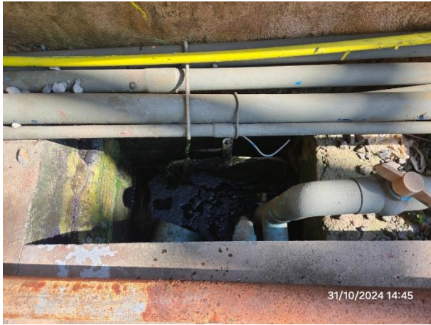
รูปที่ 13 ตะแกรงดักขยะบ่อหน่วยสุดท้ายก่อนลงทะเล
