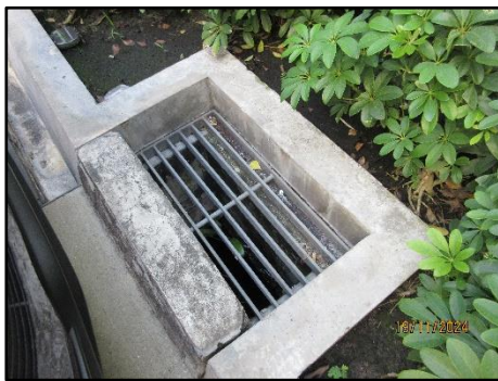
รูปที่ 53 ท่อระบายน้ำเป็นท่อระบายน้ำคอนกรีตเสริมเหล็ก
