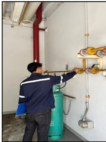
รูปที่ 18 ตำแหน่งวาล์วปิดก๊าซ สะพานไฟ สำหรับตัดกระแสไฟฟ้าที่มองเห็นได้อย่างชัดเจน
