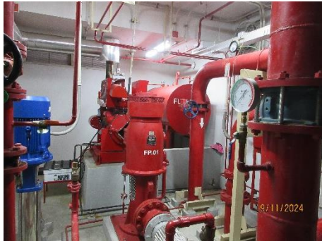
รูปที่ 62 ระบบน้ำสำรองดับเพลิง ในถังเก็บน้ำใต้ดิน
