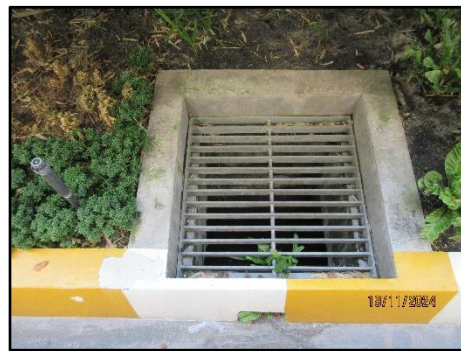
รูปที่ 44 รางระบายน้ำ เพื่อรวบรวมน้ำเสียจากการชะล้าง
