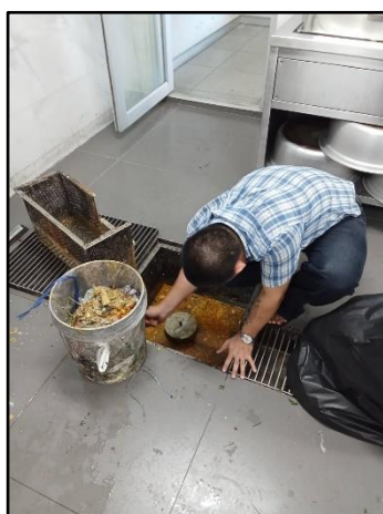
รูปที่ 22 แม่บ้านตักกากตะกอนที่ถังดักไขมัน
