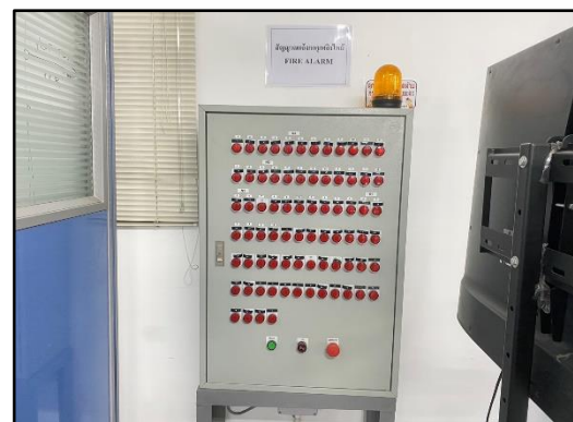
รูปที่ 78 เครื่องแจ้งเหตุเตือนเพลิงไหม้ด้วยกระดิ่งแจ้งเหตุเพลิงไหม้ (Alarm Bell)
