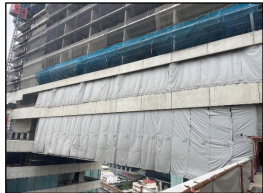
รูปที่ 21 ตาข่ายดักป้องกันวัสดุตกหล่นโดยรอบอาคาร
