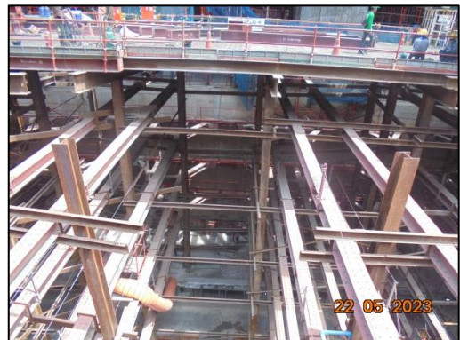
รูปที่ 38 พังกันดิน (Diaphragm Wall) และค้ำยันเหล็ก (Bracing)
