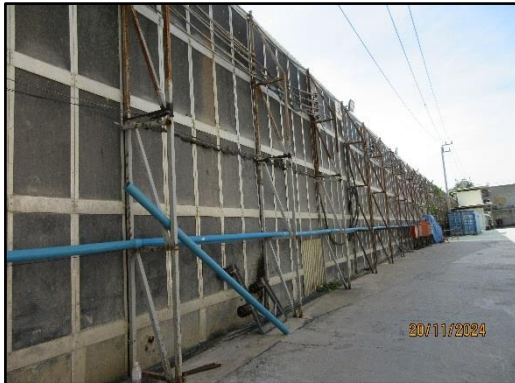
รูปที่ 12 รั้ว Metal Sheet (แผ่นเหล็กกรีดลอน) ความสูง 6 เมตร
