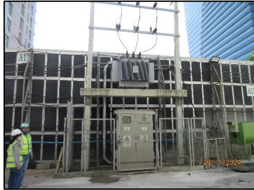
รูปที่ 70 การติดตั้งหม้อแปลงไฟฟ้าแยกจากชุมชน
