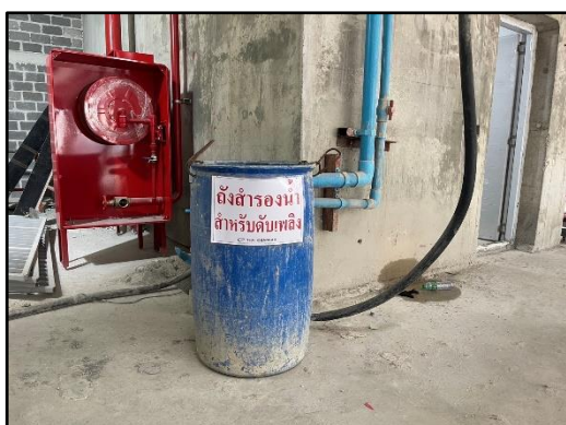
รูปที่ 65 ถังน้ำสำรองดับเพลิงบนอาคาร
