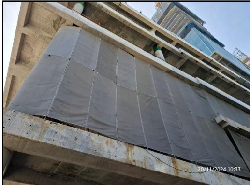
รูปที่ 20 Mesh Sheet (ชนิดกันไฟลาม) ตั้งแต่ชั้นล่างจนถึงชั้นสูงสุดโดยรอบอาคาร
