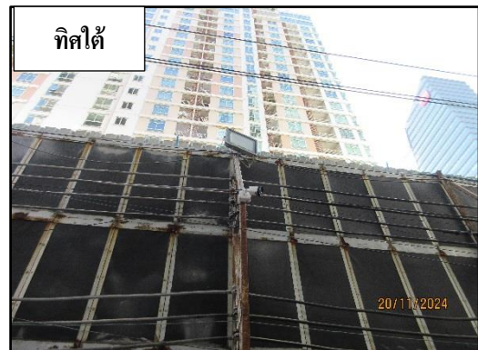
รูปที่ 12 รั้ว Metal Sheet (แผ่นเหล็กกรีดลอน) ความสูง 6 เมตร
