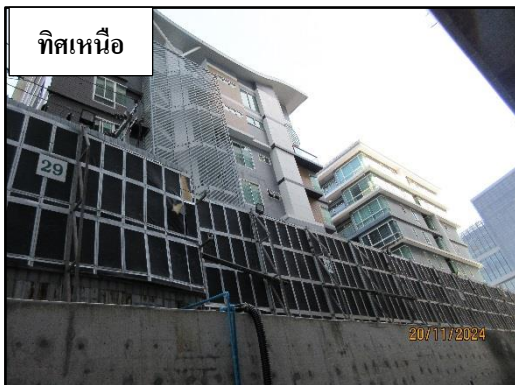
รูปที่ 12 รั้ว Metal Sheet (แผ่นเหล็กกรีดลอน) ความสูง 6 เมตร
