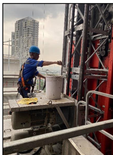
รูปที่ 33 ใช้น้ำมันหล่อลื่นช่วยลดการเสียดสี
