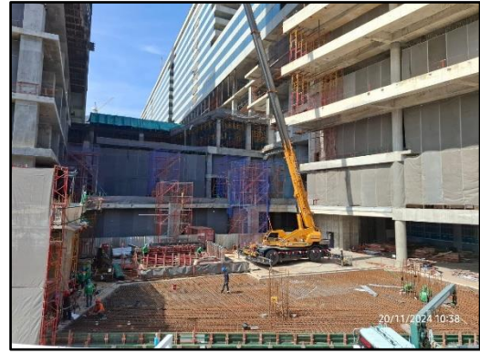
รูปที่ 36 การใช้เครนเคลื่อนย้ายอุปกรณ์ก่อสร้าง
