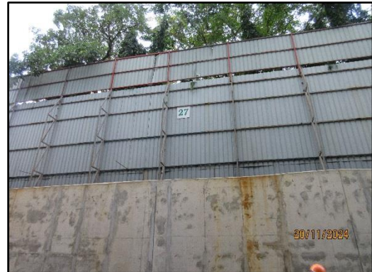
รูปที่ 12 รั้ว Metal Sheet (แผ่นเหล็กกรีดลอน) ความสูง 6 เมตร
