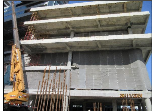
รูปที่ 20 Mesh Sheet (ชนิดกันไฟลาม) ตั้งแต่ชั้นล่างจนถึงชั้นสูงสุดโดยรอบอาคาร
