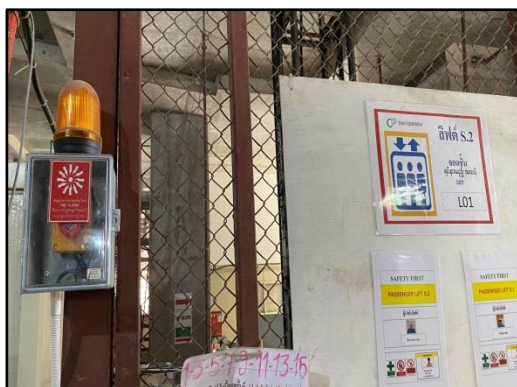
รูปที่ 78 เครื่องแจ้งเหตุเตือนเพลิงไหม้ด้วยกระดิ่งแจ้งเหตุเพลิงไหม้ (Alarm Bell)
