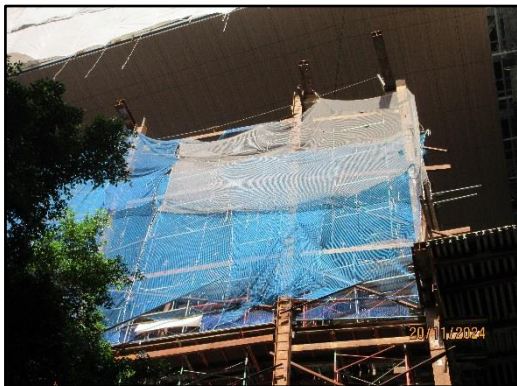
รูปที่ 21 ตาข่ายดักป้องกันวัสดุตกหล่นโดยรอบอาคาร
