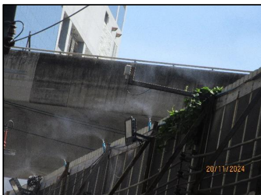
รูปที่ 26 ระบบผันละอองสเปรย์น้ำกันฝุ่นบริเวณแนวรั้ว
