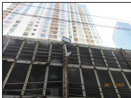
รูปที่ 26 ระบบผันละอองสเปรย์น้ำกันฝุ่นบริเวณแนวรั้ว
