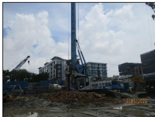
รูปที่ 32 ก่อสร้าง โดยใช้เสาเข็มเพื่อป้องกันผลกระทบต่อผู้อยู่ใกล้เคียง
