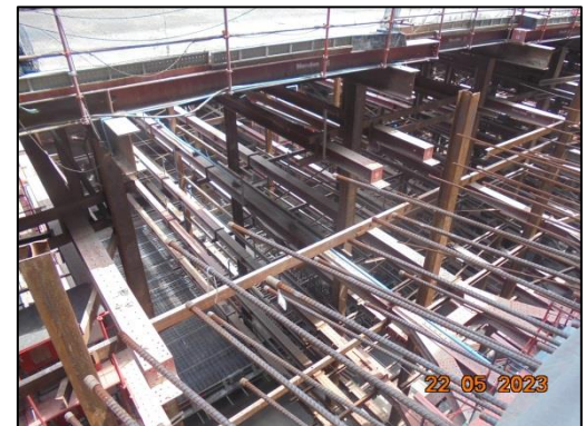
รูปที่ 38 พังกันดิน (Diaphragm Wall) และค้ำยันเหล็ก (Bracing)
