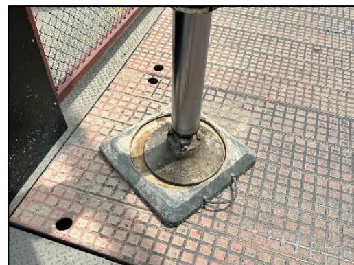
รูปที่ 123 วัสดุป้องกันและดูดซับการสั่นสะเทือนรองรับไว้ได้เครื่องจักร
