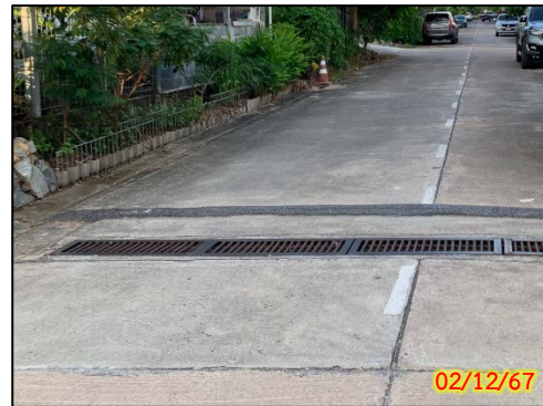
รูปที่ 2.2-8 รางระบายน้ำภายในโครงการ
