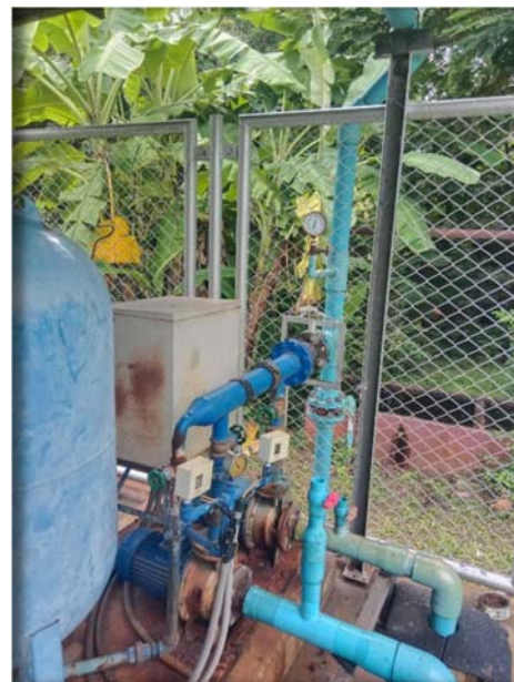
รูปที่ 1.6 การสูบล้างตะกอนออกจากระบบบำบัดไปกำจัด
