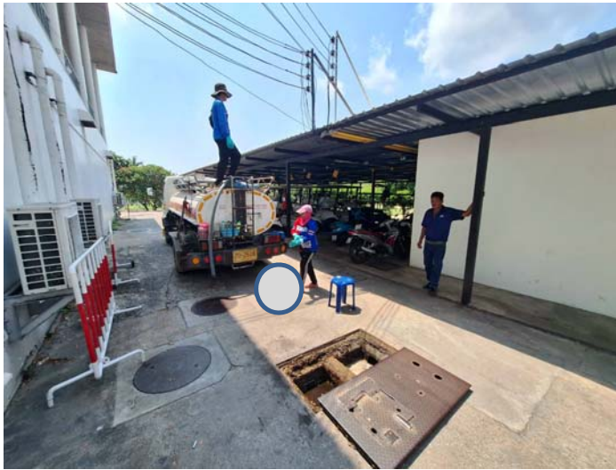
รูปที่ 1.6 การสูบล้างตะกอนออกจากระบบบำบัดไปกำจัด
