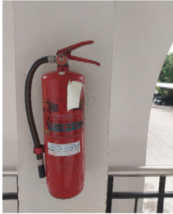
รูปที่ 3.2(2) จัดให้มีถังดับเพลิงชนิดมือถือ ชนิด Dry Chemical ขนาด 10 ปอนด์
