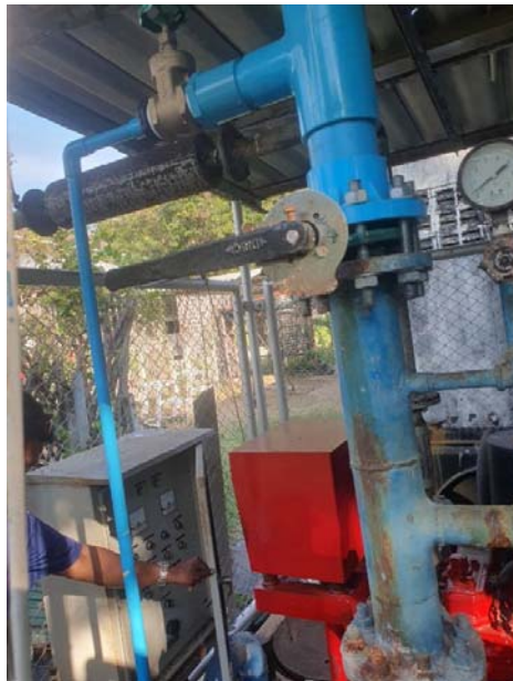
รูปที่ 1.6 การสูบล้างตะกอนออกจากระบบบำบัดไปกำจัด
