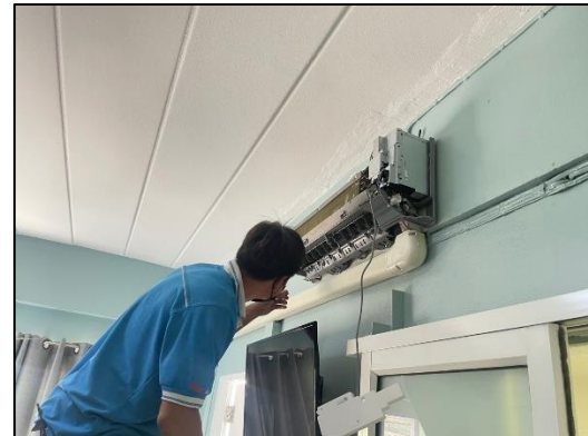
ภาพที่ 39 กิจกรรมทำความสะอาดเครื่องปรับอากาศ
