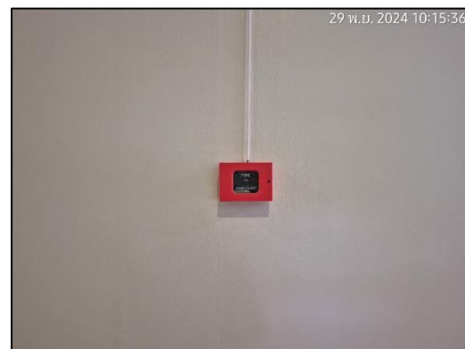
ภาพที่ 22 ระบบแจ้งเหตุแบบใช้มือดึง (Manual Station)
