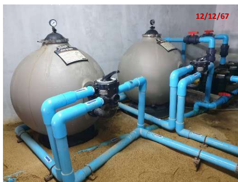
ภาพที่ 2.2-13 ระบบกรองของสระว่ายน้ำ
