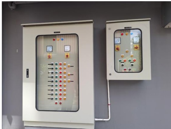
รูปที่ 2-14 ระบบมิเตอร์ไฟฟ้าสำหรับระบบบำบัดน้ำเสีย
