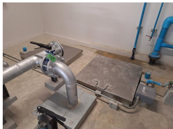
รูปที่ 2-17 ถังสำรองน้ำใต้ดิน
