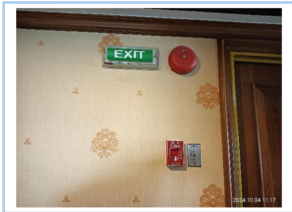
รูปที่ 3-62 อุปกรณ์ส่งเสียงสัญญาณเตือนภัย
