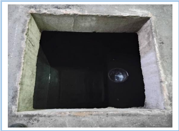
รูปที่ 3-18 Weir บริเวณบ่อพักน้ำบ่อสุดท้ายก่อนระบาย ออกไปยังท่อระบายน้ำของ ททท.
