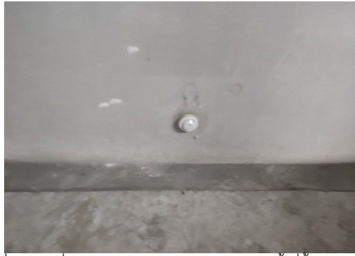
ภาพที่ 5-29 เครื่องตรวจจับก๊าซ LPG และ NGV ติดตั้งที่ชั้นจอดรถใต้ดิน
