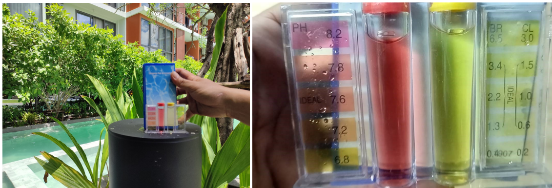
ภาพที่ 5-39 ทำความสะอาดสระว่ายน้ำ และตรวจค่า pH และ Chlorine ทุกวัน
