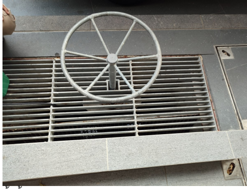
ภาพที่ 5-14 บ่อพักน้ำที่มีตะแกรงดักขยะ และ Stop Log ไม่มีขยะอุดตันสามารถระบายน้ำได้ดี
