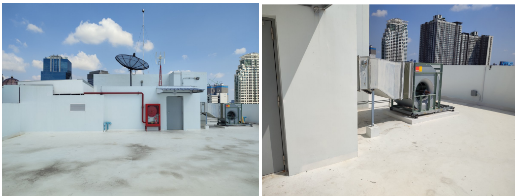
ภาพที่ 5-33 บันไดหนีไฟ และพัดลมอัดอากาศ
