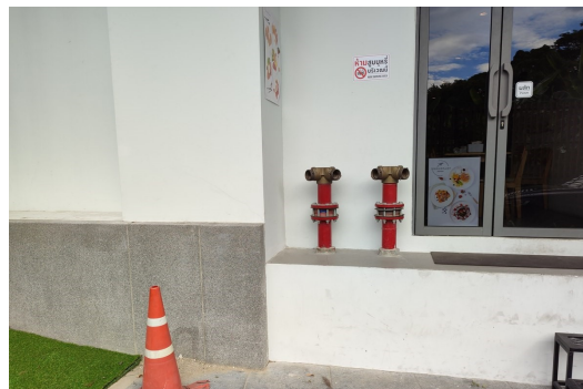
ภาพที่ 5-30 หัวรับน้ำดับเพลิงจากภายนอกอาคาร
