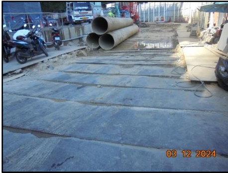
รูปที่ 69 แผ่นเหล็กอย่างหนาปูให้ทั่วบริเวณที่มีรถวิ่งผ่านภายในพื้นที่ก่อสร้าง
