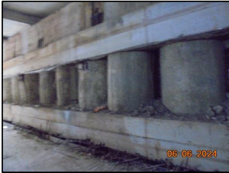
รูปที่ 31 ผนังกันดิน (Diaphragm Wall)
