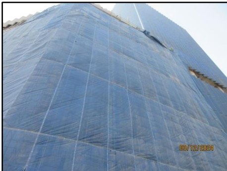
รูปที่ 9 ติดตาข่ายกันฝุ่น (Mesh sheet) คลุมโดยรอบอาคาร
