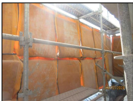
รูปที่ 22 กำแพงกันเสียงติดตามชั้นอาคารที่กำลังก่อสร้าง
