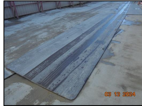
รูปที่ 69 แผ่นเหล็กอย่างหนาปูให้ทั่วบริเวณที่มีรถวิ่งผ่านภายในพื้นที่ก่อสร้าง
