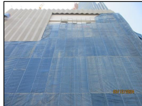
รูปที่ 9 ติดตาข่ายกันฝุ่น (Mesh sheet) คลุมโดยรอบอาคาร
