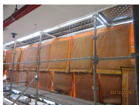
รูปที่ 22 กำแพงกันเสียงติดตามชั้นอาคารที่กำลังก่อสร้าง
