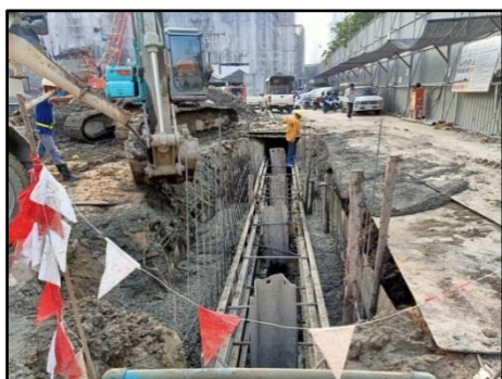
รูปที่ 30 ขุดคูเพื่อลดแรงสั่นสะเทือน
