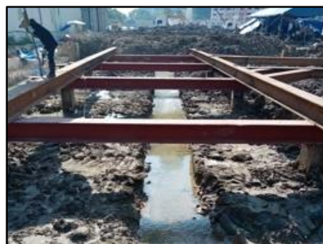
รูปที่ 30 ขุดคูเพื่อลดแรงสั่นสะเทือน
