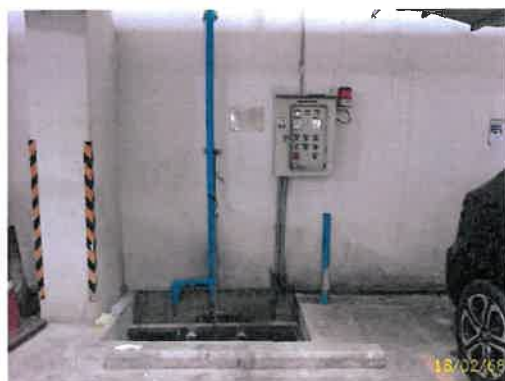
ตู้ควบคุม และบ่อบักน้ำชั้นใต้ดิน
