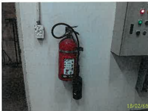
ถังดับเพลิงเคมีแบบมีมือถือ CO 2
