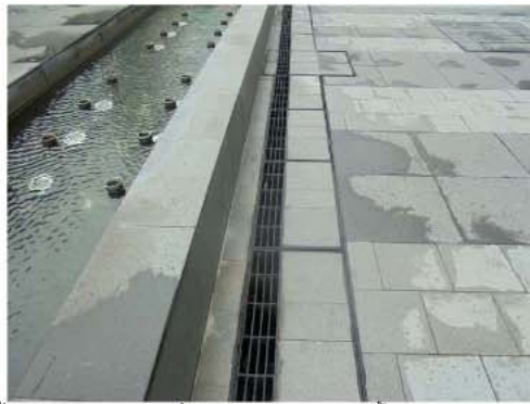
ภาพที่ 3-39 ระบบ Stop log ใช้ระดับน้ำภายในโครงการเมื่อถึงระดับท่อระบายน้ำออกจะไหลล้นออก และน้ำภายนอกไม่สามารถไหลเข้า
