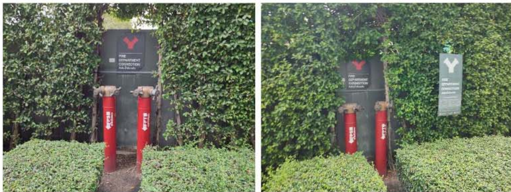
ภาพที่ 3-24 หัวรับน้ำดับเพลิงจากภายนอกอาคาร
