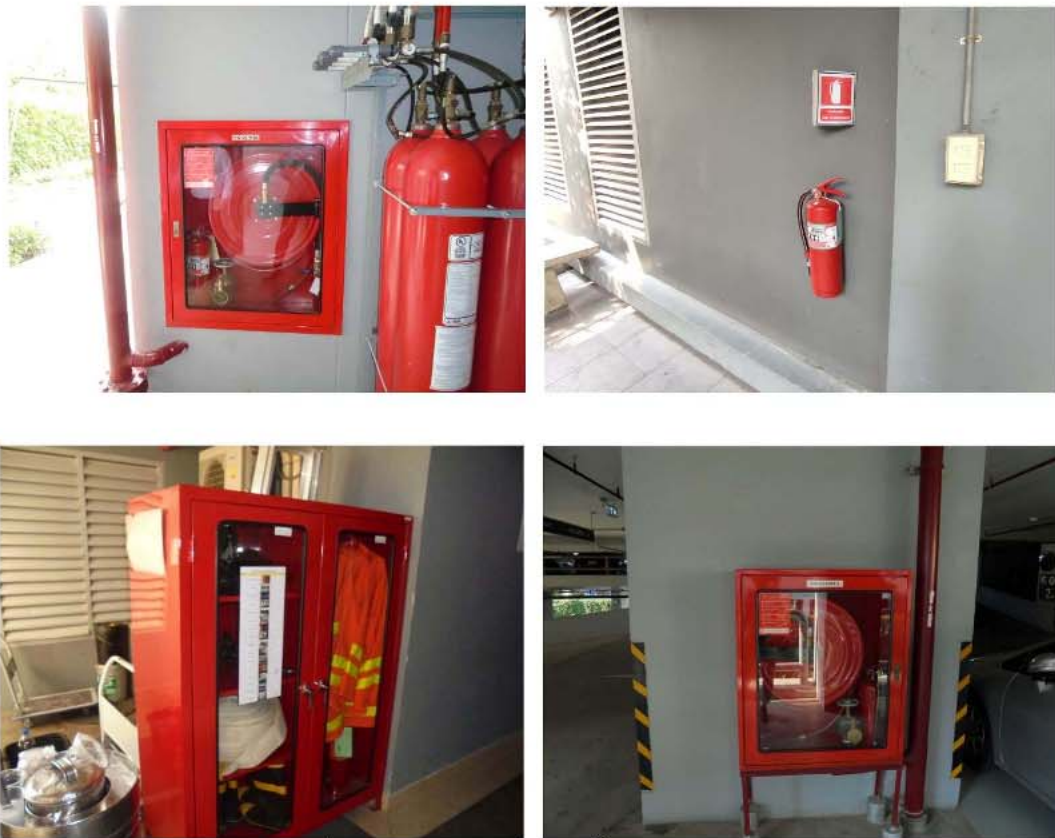
ภาพที่ 3-23 ท่อยี่น และตู้เก็บสายฉีดน้ำดับเพลิงและอุปกรณ์
