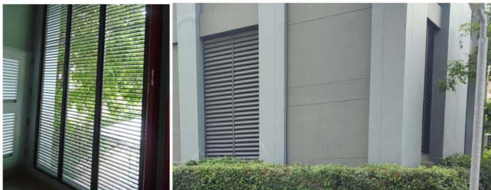
ภาพที่ 3-13 ช่องเปิดระบายอากาศที่ห้องเครื่องไฟฟ้า
