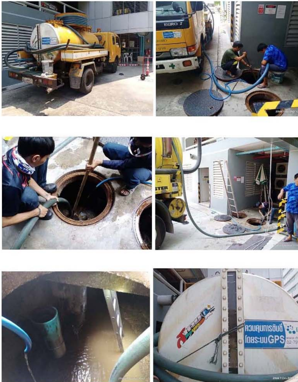
ภาพที่ 3-25 คูตะกอนบ่อบำบัดน้ำเสีย และบ่อดักไขมัน
