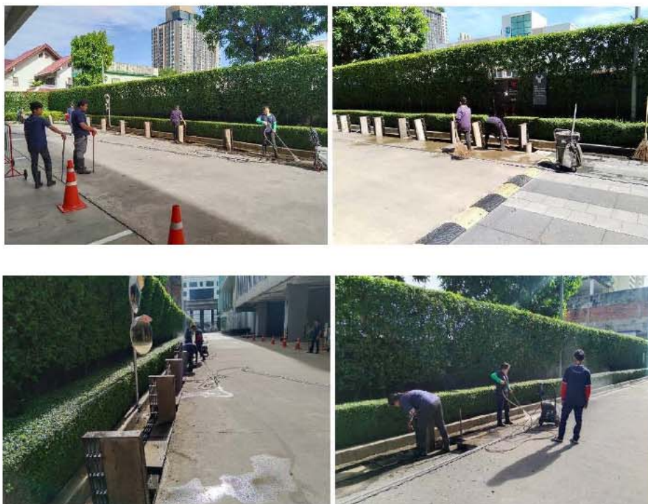
ภาพที่ 3-36 ขุดลอกท่อระบายน้ำและบ่อพักน้ำ
