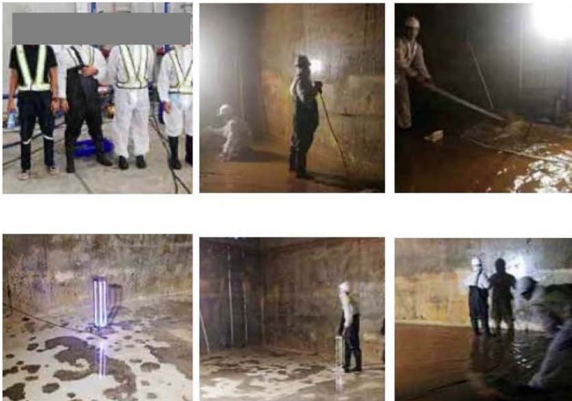
ภาพที่ 3-35 ล้างทำความสะอาดบ่อสำรองน้ำใช้
