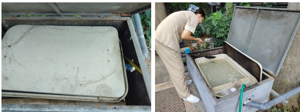
ภาพที่ 4-35 ตักไขมันที่ติดถังไขมันจากน้ำทิ้งห้องครัว
