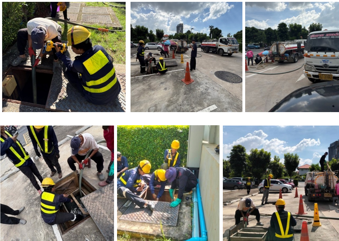
ภาพที่ 4-9 ระบบบำบัดน้ำเสีย บำรุงรักษาระบบบำบัดน้ำเสียและสูบน้ำจากบ่อเก็บตะกอน
