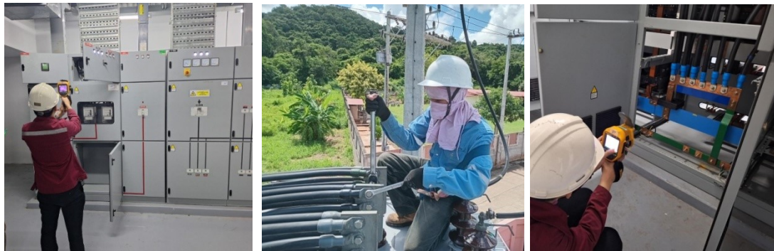
ภาพที่ 4-3 ห้องเครื่องไฟฟ้าและห้องเครื่องกำเนิดไฟฟ้าฉุกเฉิน และตรวจสอบเป็นประจำทุกสัปดาห์
