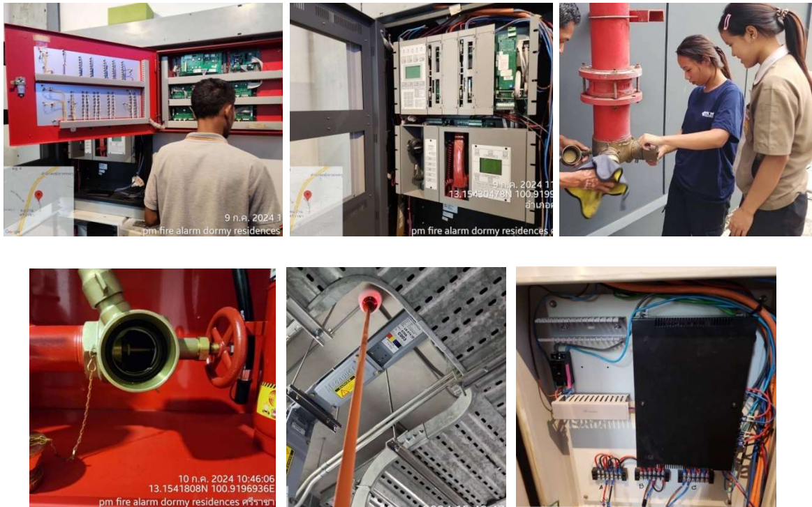
ภาพที่ 4-21 ตรวจสอบระบบเตือนและป้องกันอัคคีภัย และผังทางหนีไฟ และป้ายบอกชั้นของอาคาร
