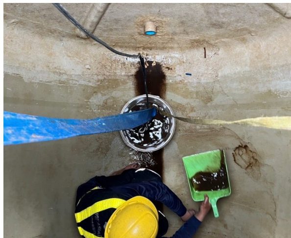
ภาพที่ 4-33 ล้างบ่อสำหรับน้ำใช้ที่ชั้นดาดฟ้า
