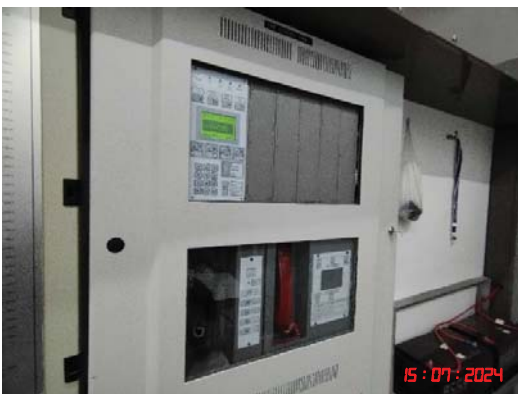
แผงควบคุมระบบสัญญาณแจ้งเหตุเพลิงไหม้
