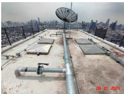
รูปที่ 7 ถังเก็บน้ำสำรอง
