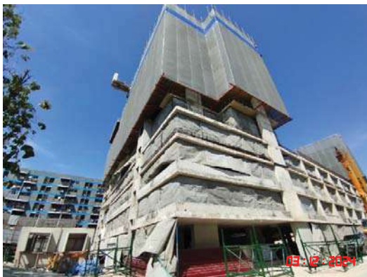
รูปที่ 6 การติดตั้ง Mesh Sheet รอบตัวอาคาร และตาข่ายกันตก
