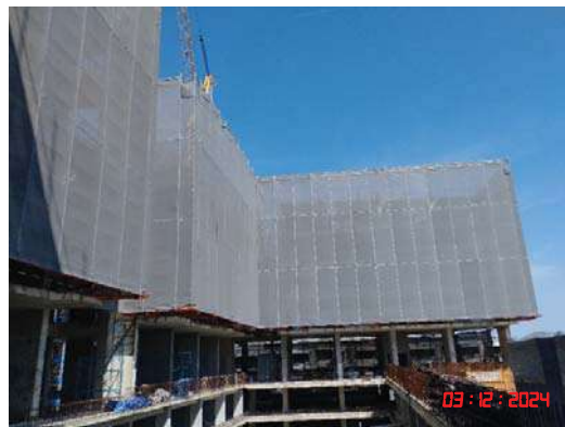
รูปที่ 6 การติดตั้ง Mesh Sheet รอบตัวอาคาร และตาข่ายกันตก
