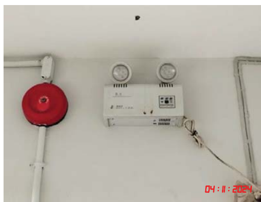
ไฟส่องสว่างฉุกเฉินและสัญญาณเตือนเพลิงไหม้แบบกริ่ง
