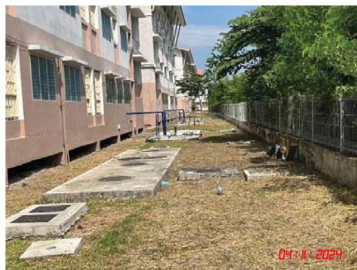
รูปที่ 5 ระบบบำบัดน้ำเสียประจำอาคาร
