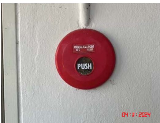
สัญญาณแจ้งเหตุเพลิงไหม้แบบใช้มือกด
