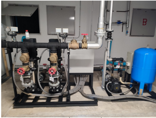
ภาพที่ 3-7 ห้องเครื่องประปา และช่างโครงการตรวจสอบระบบประปาและท่อต่าง ๆ
