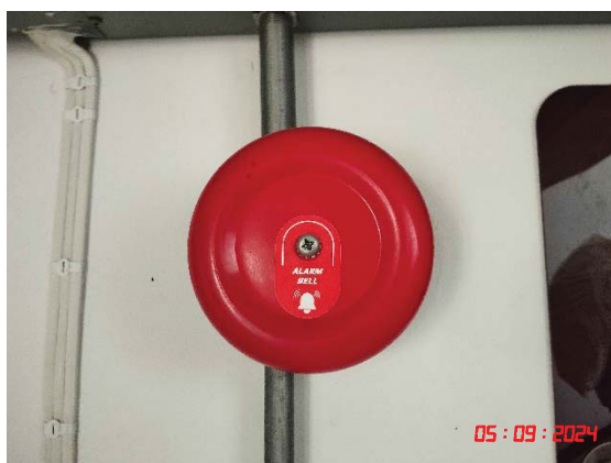
ระบบสัญญาณเตือนไฟไหม้แบบกริ่ง
