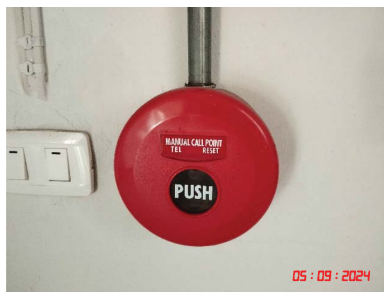
ระบบสัญญาณเตือนไฟไหม้แบบใช้มือกด
